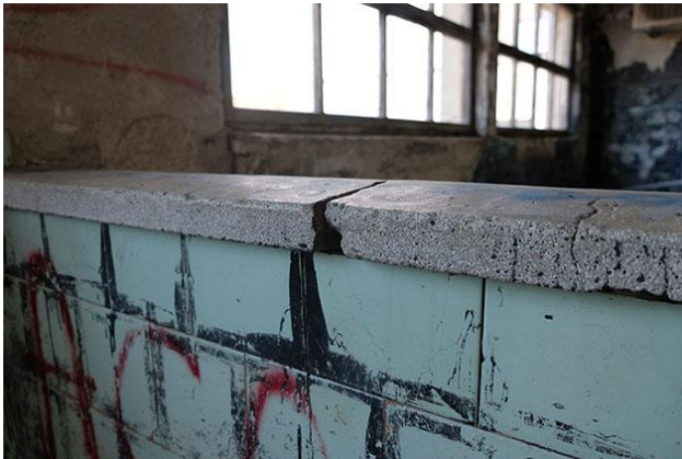
parapet i betonska klupčica
