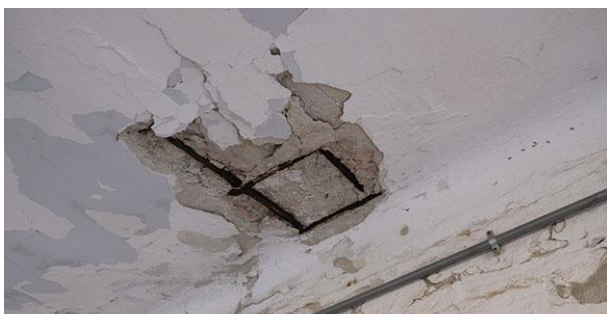
strop s oštećenjem ispune od opeke
