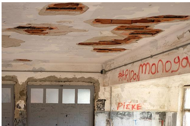
strop s oštećenjem ispune od opeke
