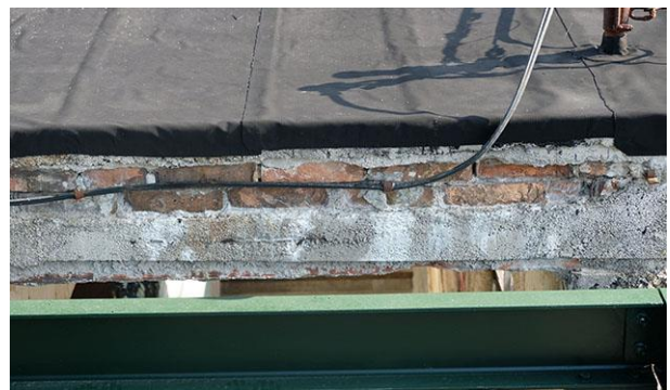
detalj postojećeg stanja krova
