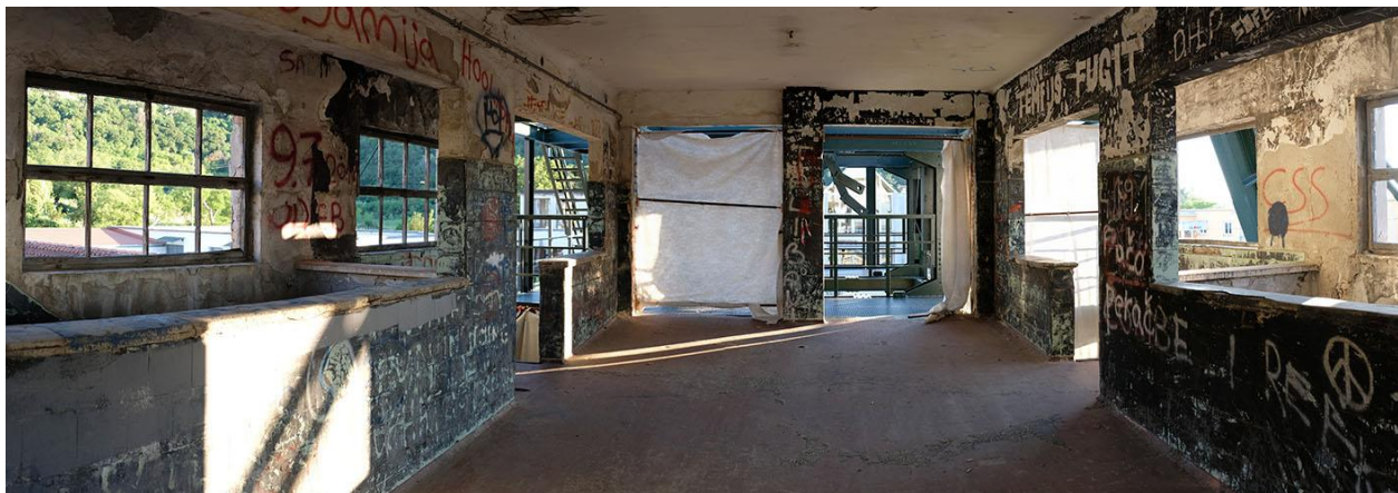
unutrašnjost kata 'tople veze' – pogled na zapadni zid
