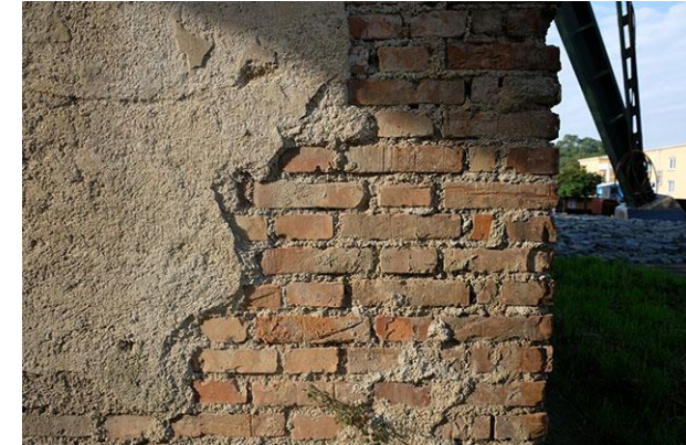
detalj strukture zida ispod žbuke
